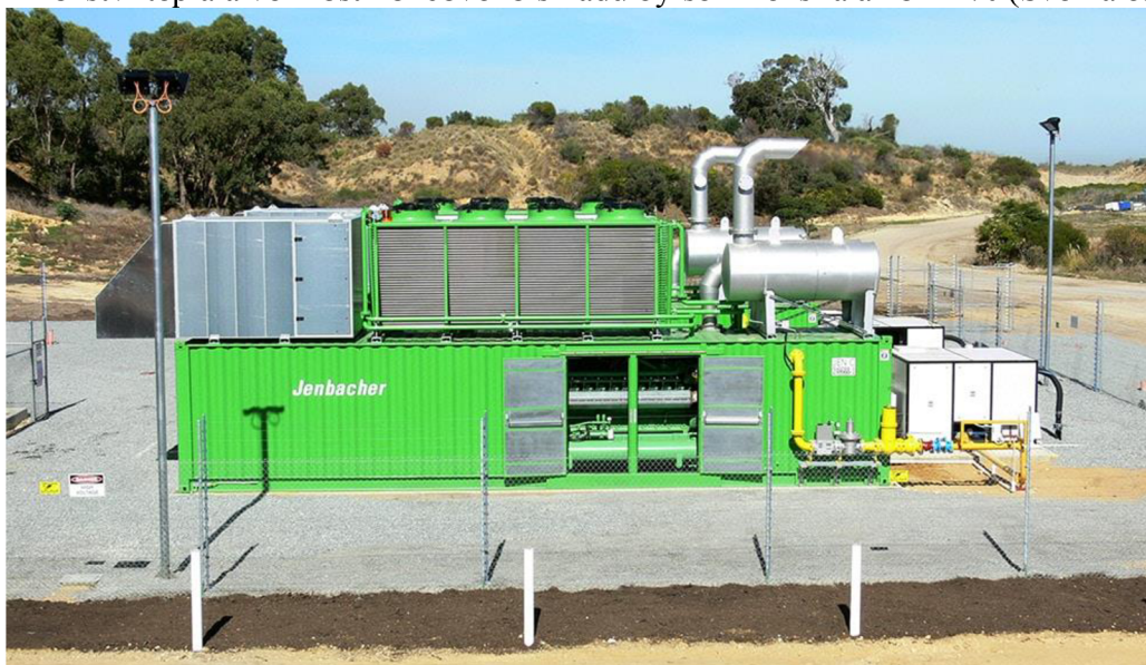
Obrázek 13: Kompletní vysokoúčinná kogenerační jednotka Jenbacher, které v česku ve svých realizacích používá společnost Farmtec
