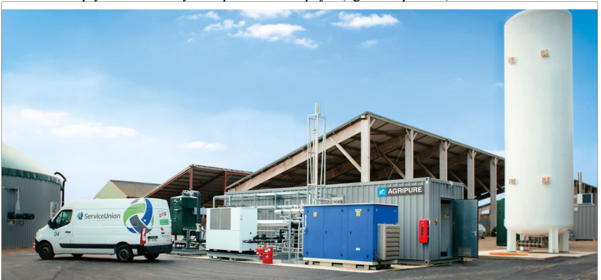
Obrázek 2: Ukázka zařízení na upgrading bioplynu od společnosti agriKomp
