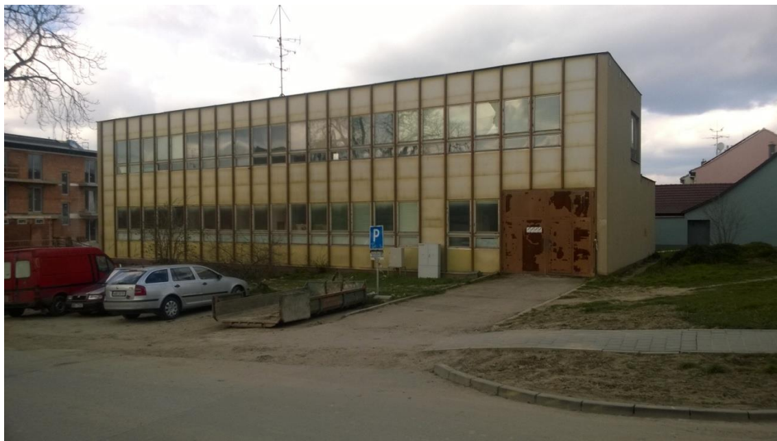
Obrázek 5: Bývalá svářečská škola
