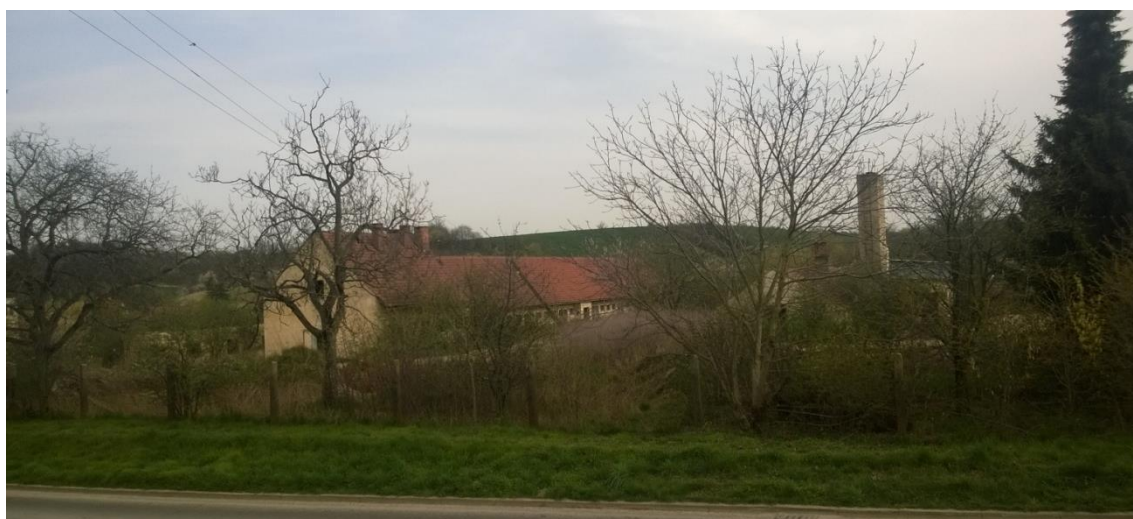
Obrázek 5: Brownfield bývalého vepřína
