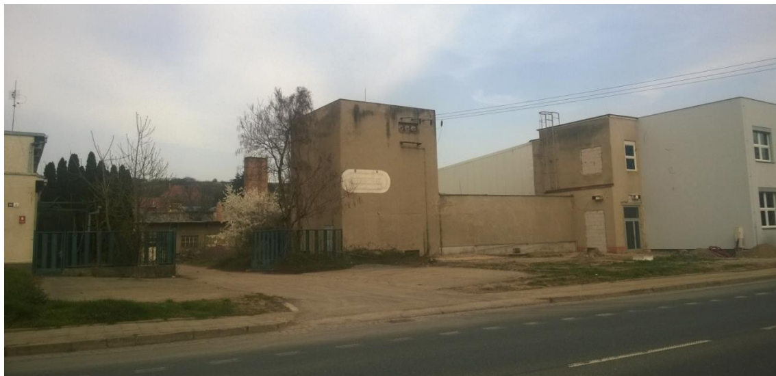
Obrázek 4: Objekt bývalého průmyslového areálu, nyní částečně v rekonstrukci
