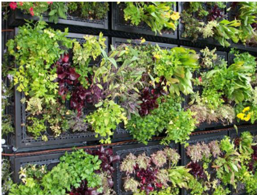
Obrázek 6: Modulový typ živoucí stěny (Manso & Castro-Gomes, 2015).
