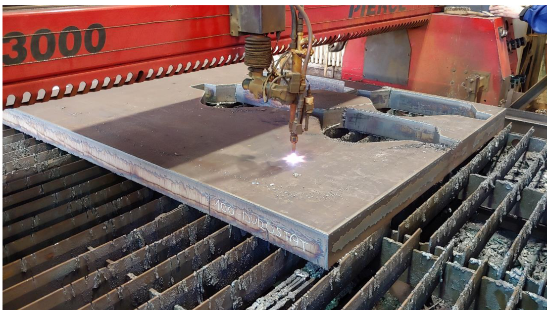
Obr. 12 Řezání kyslík-acetylenovým hořákem na stroji PIERCE RUR 3000.
