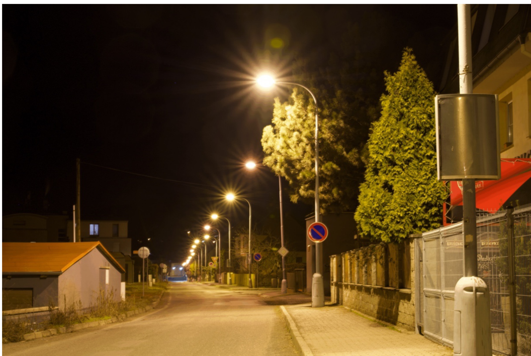
Obr. 55 Ukázka veřejného osvětlení ulice Březinova cesta v Litoměřicích (Zdroj: Autor)
