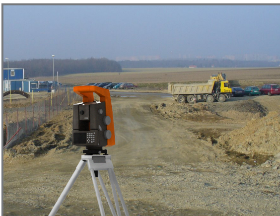
Obr. 67 Použití totální stanice v terénu.
