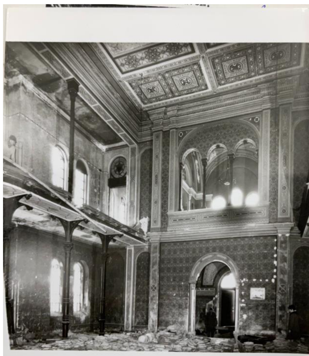
[8] Táborská synagoga, interiér synagogy jeden rok před zbouráním.
