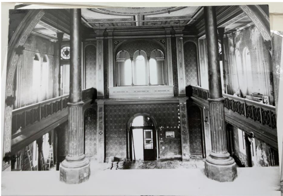
[5] Táborská synagoga, interiér synagogy jeden rok před zbouráním.
