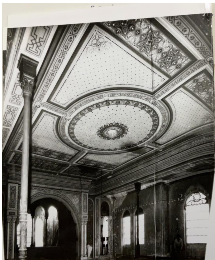
[6] Táborská synagoga, interiér synagogy jeden rok před zbouráním.
