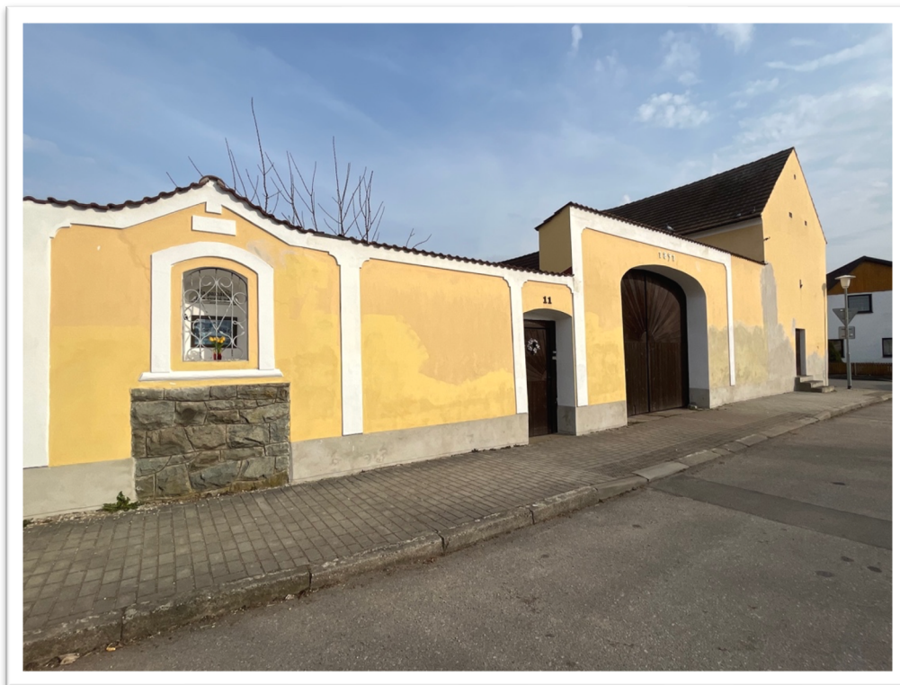
Obrázek 9, Usedlost č. 11 s vestavěnou kapličkou v Plavě (foto autora).
