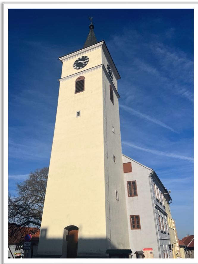
Obrázek 5, Věž bývalého kostela sv. Filipa a Jakuba ve Velešíně (foto autora).
