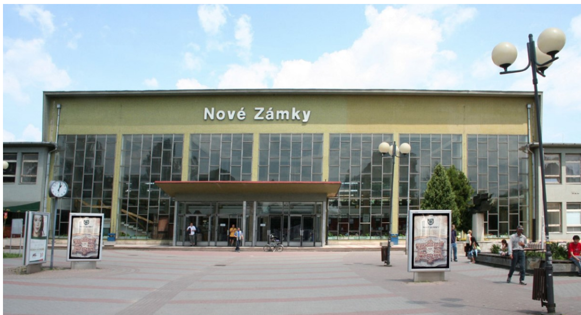
Obr. 2.9: Železničná stanica Nové Zámky
