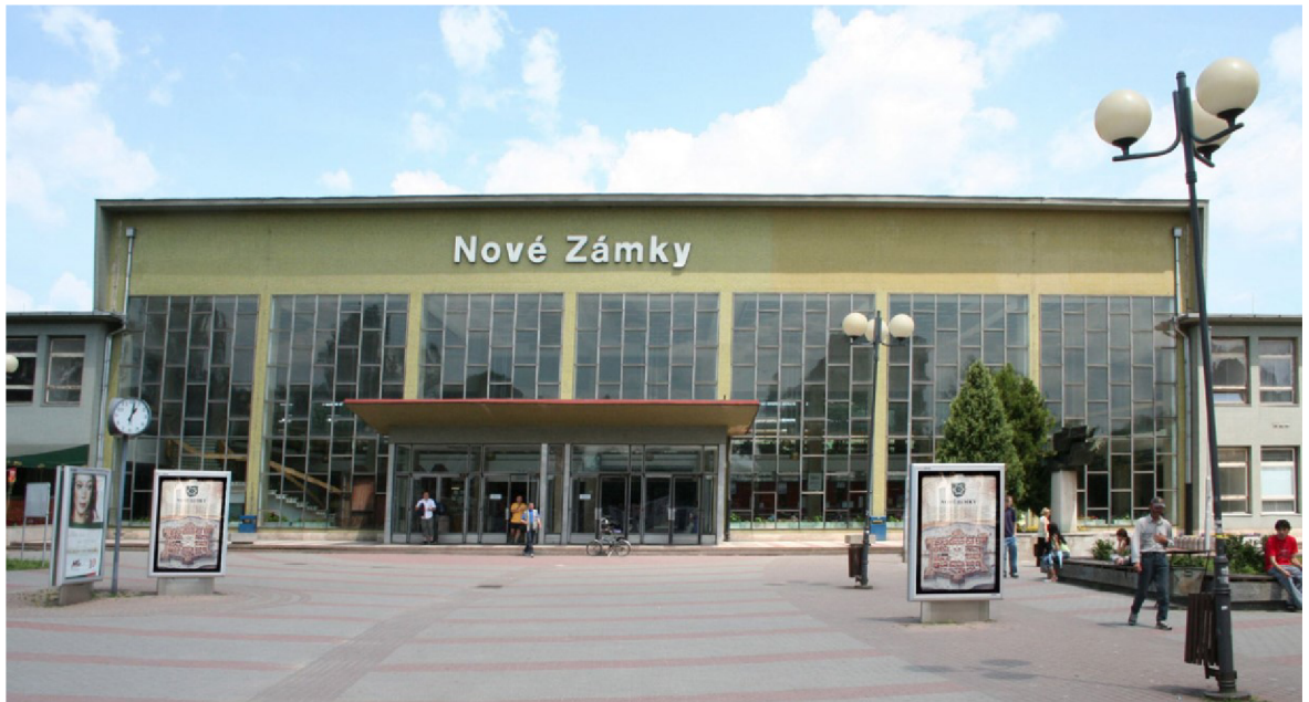
Obr. 2.9: Železničná stanica Nové Zámky
