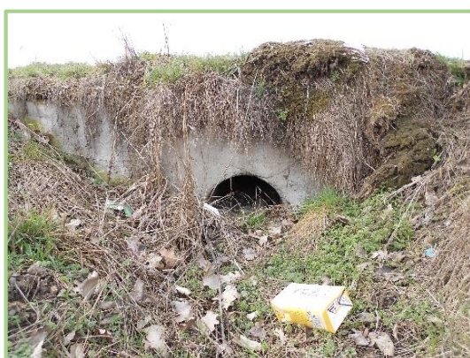
19 – Propustek u hl. silnice – východní část
