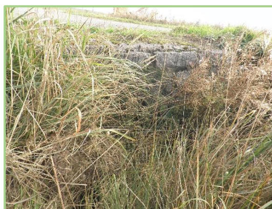
8 – Propustek u cesty CH3
