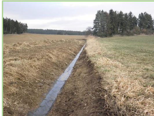
50 – Upravená odvodňovací stoka ze Zakalského rybníka, vpravo remíz R25
