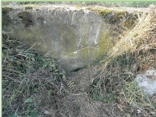
20 – Propustek u hl. silnice – západní část
