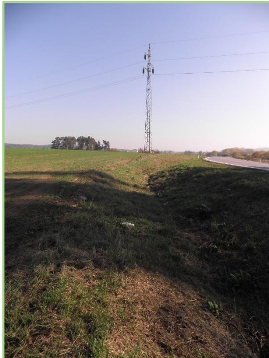
21 – Příkop u hl. silnice – západní část, stožár vedení VVN
