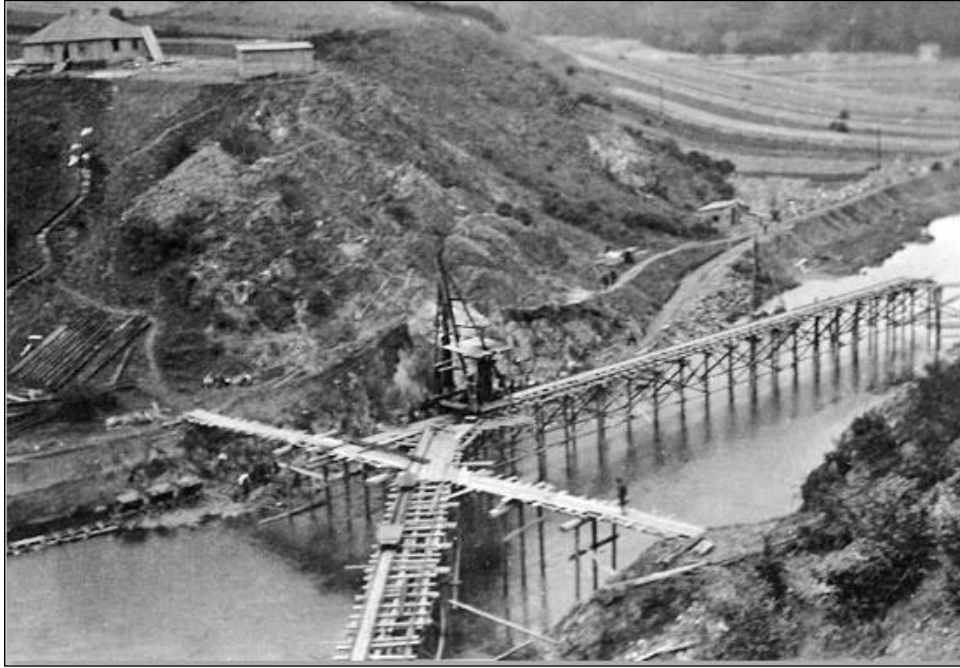
Obrázek č. 2 - Zahájení stavby přehradní hráze [6]
