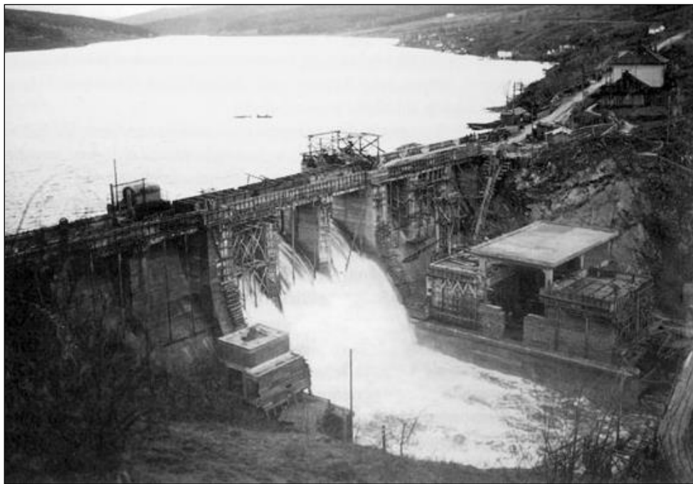
Obrázek č. 5 – Přehrada po úplném napuštění [6]
