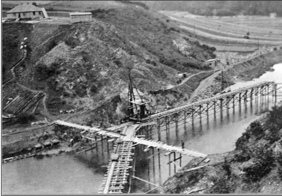
Obrázek č. 2 - Zahájení stavby přehradní hráze [6]
