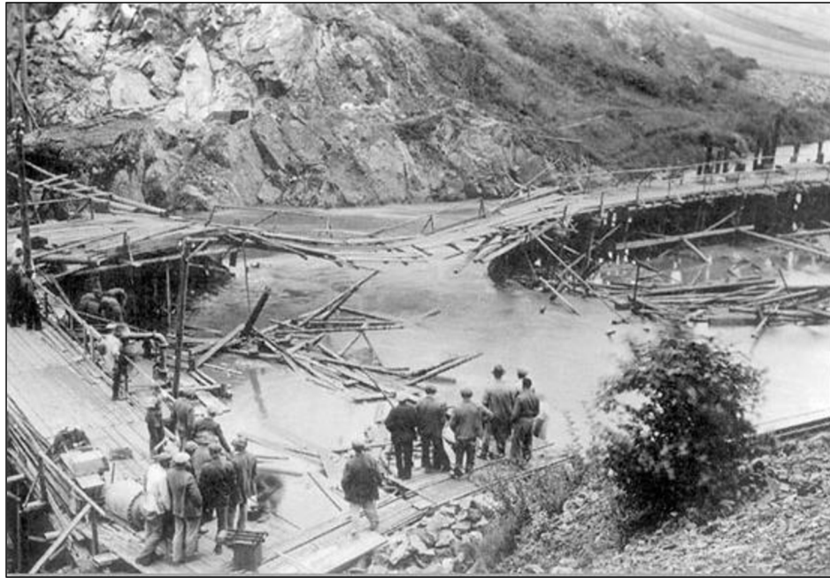
Obrázek č. 3 - Zničení stavby hráze povodní v létě 1937 [6]
