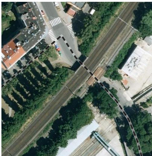
Obr. 3.7 Podjezd pod železničním mostem nad ulicí Šamalova
