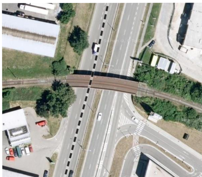
Obr. 3.3 Podjezd pod železničním mostem nad ulicí Heršpická
