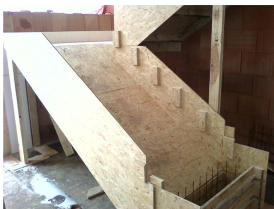
Obr. 6.7 Příklad bednění schodiště
