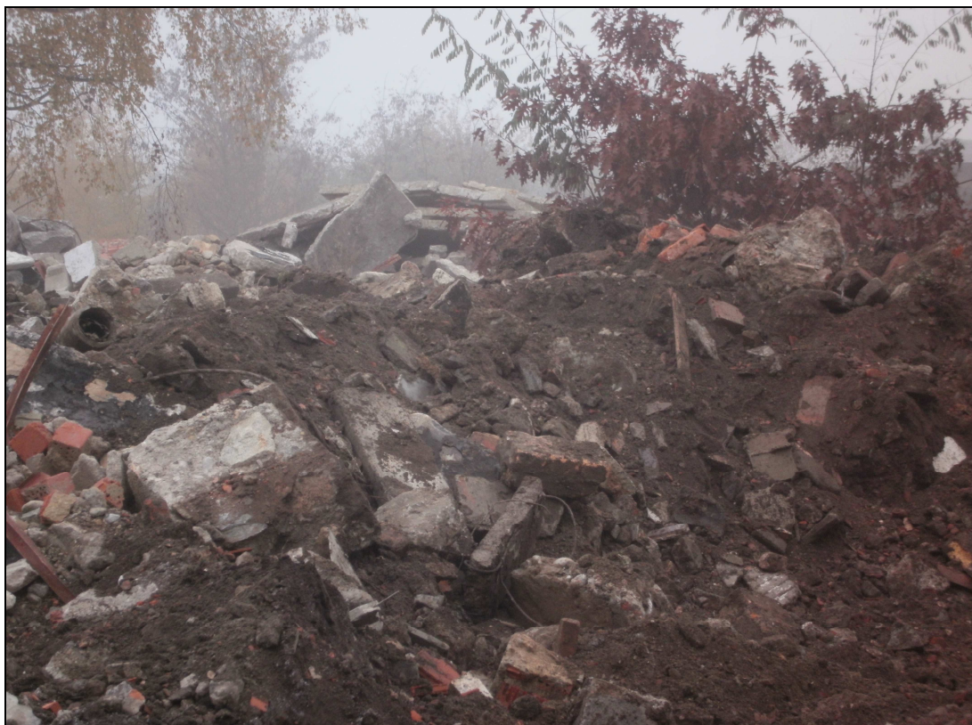
Obrázek 24 – Demoliční odpad zpracováváný mobilní drticí jednotkou HARTL PC 1265 J
