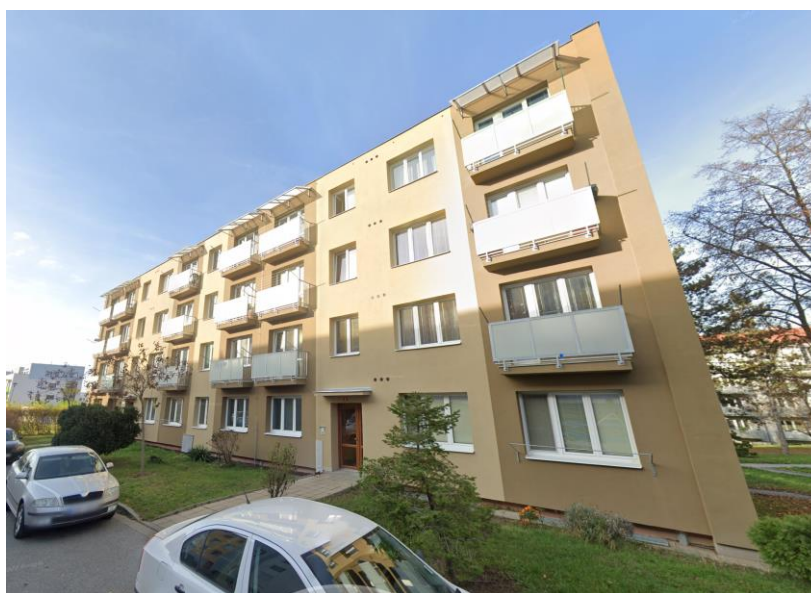
Obrázok 4.1 - Fotografia južnej strany bytového domu
