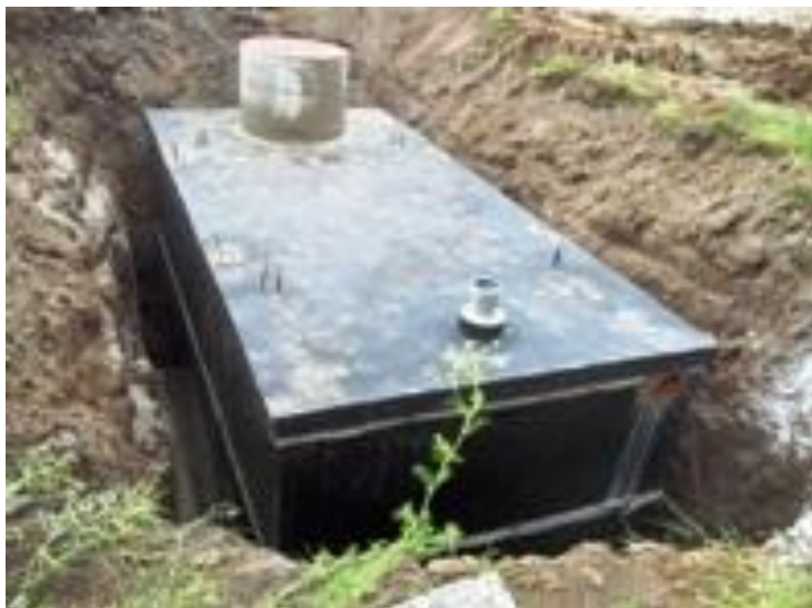
Obrázek č. 8 Žumpa betonová
