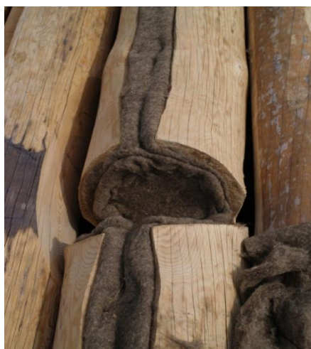
Obr. 4.8 Izolace z ovčí vlny vložená do sedla a drážky srubového trámu ( www.sruby-roubenky.cz )
