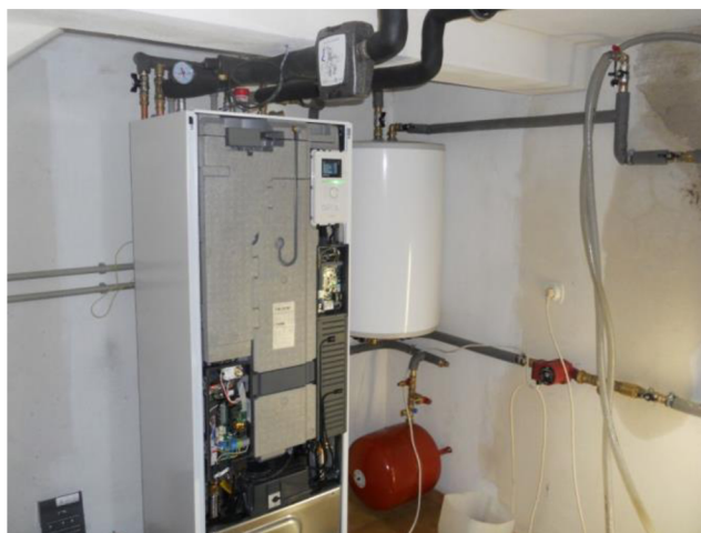
Obr. 3-4 Tepelné čerpadlo s plošným kolektorem, NIBE [29]
