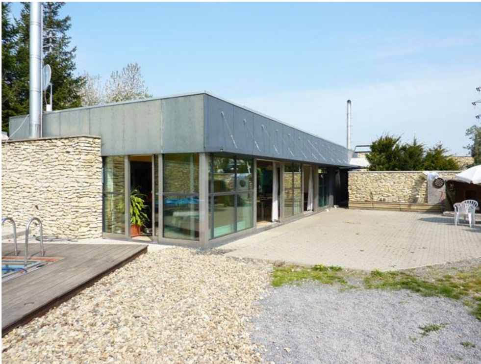
Obr. 5-2 Fotografie ostrovního domu, Praha [41]
