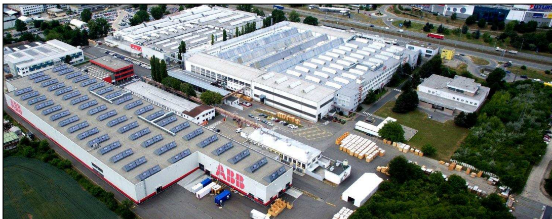
Obr. 1 Výrobní prostory ABB EPMV Brno – Vídeňská [4].
