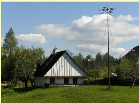
Obr. 2: Divišův rodný domek i s kopií prvního bleskosvodu [62]
