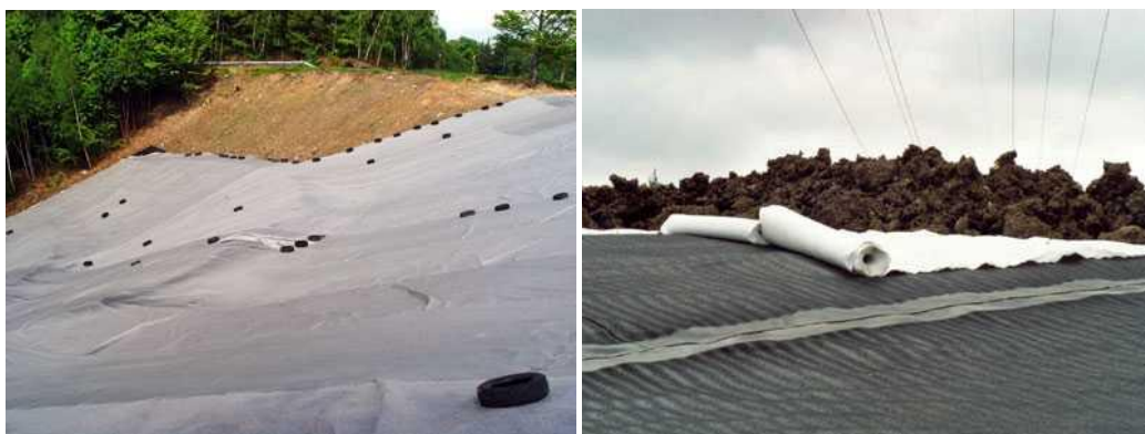
Obr. č.3 - Fólie a geotextílie
