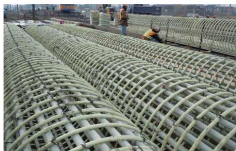
(b) GFRP armované klece pro soft-eye
