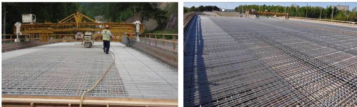
Obrázek 15 Vyztužování mostních konstrukcí (vlevo-Gateway Blvd/23 rd Ave-Alberta (2009), vpravo-410 Overpass Bridge Quebec (2012) [12]
