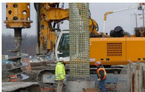
(c) Manipulace a zvedání GFRP soft-eye
