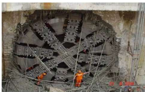
(a) TBM se prosekává skrz FRP-RC stěnu
