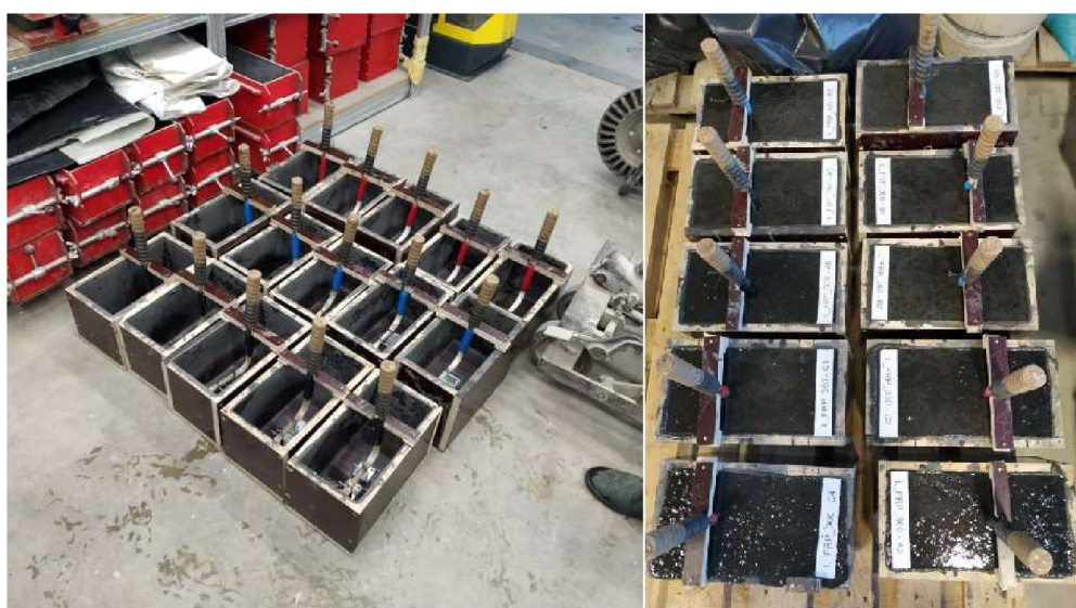
Obrázek 40 Výroba betonových bloků (vlevo-formy s výztuží před zalitím, vpravo-formy s výztuží po zalití betonem) [Aneta Blahová]
