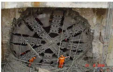
(a) TBM se prosekává skrz FRP-RC stěnu
