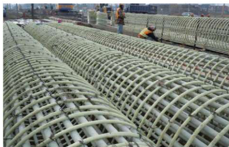
(b) GFRP armované klece pro soft-eye
