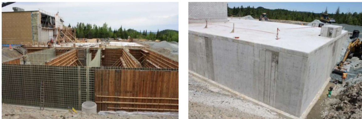
Obrázek 19 Vlevo-FRP vyztužování zdí, vpravo-vnější pohled na nádrž [12]
