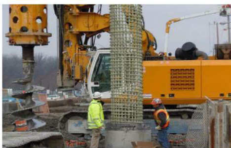
(c) Manipulace a zvedání GFRP soft-eye
