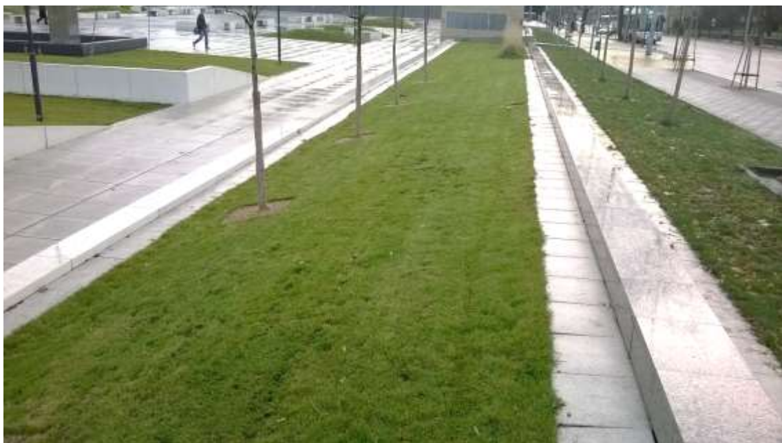
Obr.5: Príklad vhodného riešenia okrajov trávinatej plochy, vhodných pre pojazď mechanizácie (foto autor).
