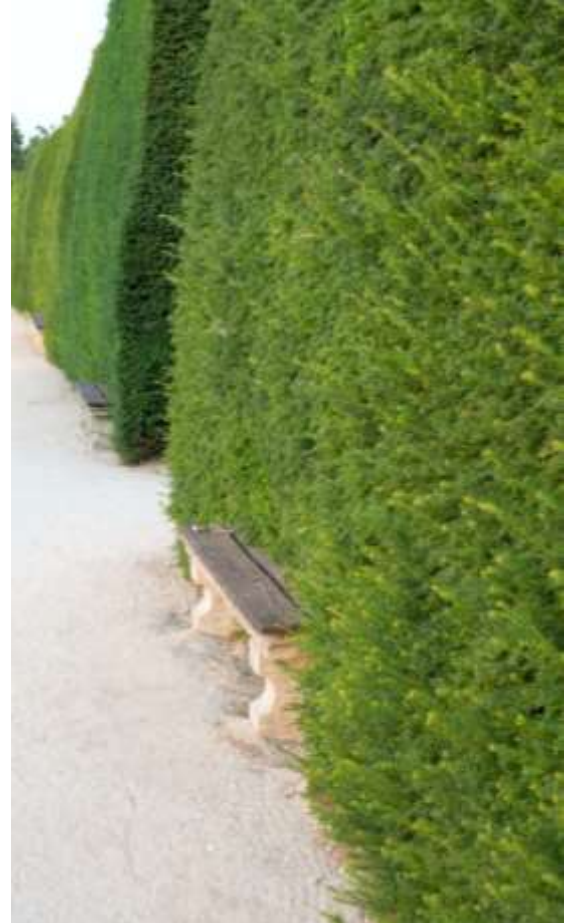
Obr.10: Nevhodná údržba tvarovanej živej steny (foto autor).
