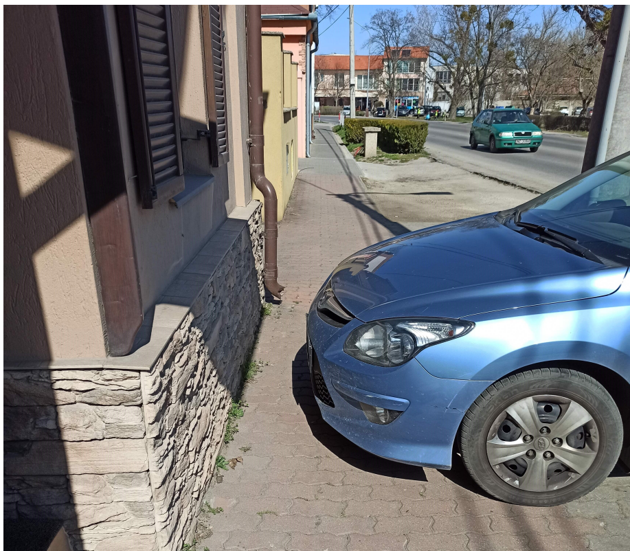
Obr. 3.108: Nedostatočná minimálna šírka na komunikácii pre chodcov. [zdroj: vlastný].
