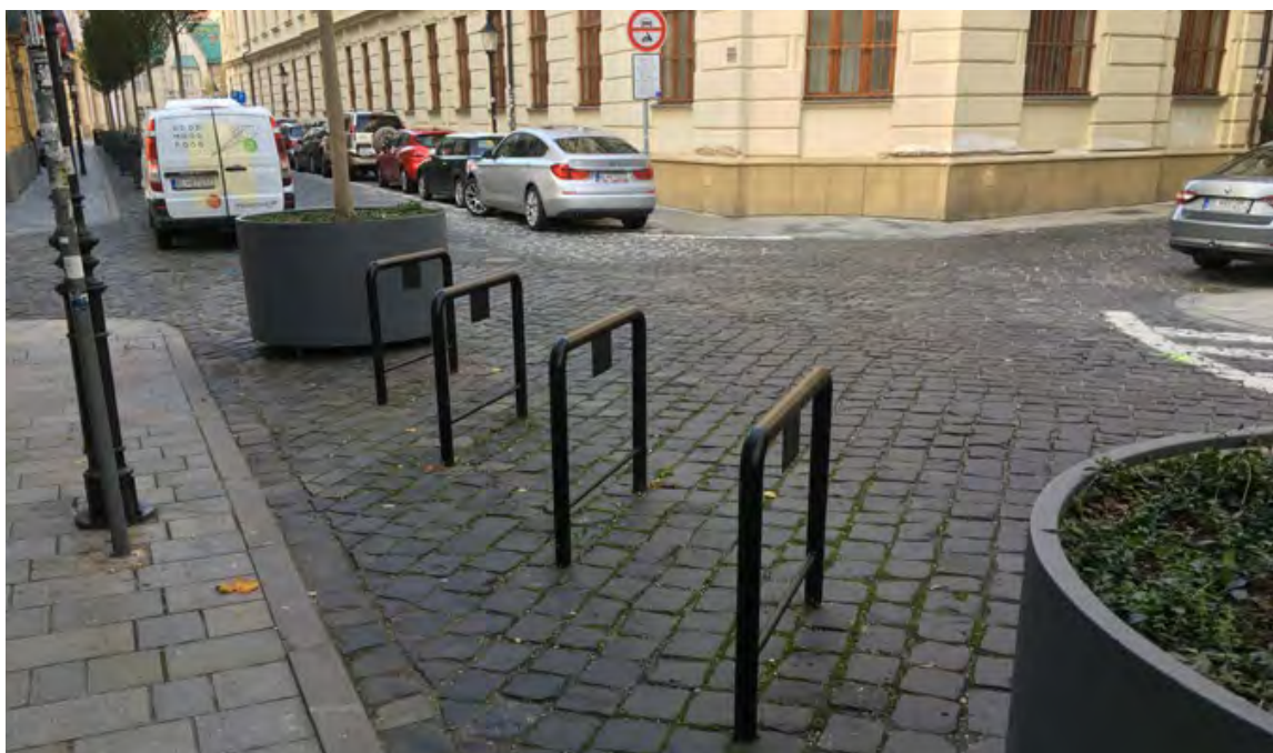
Obr. 4.14: Príklad vhodného stojanu kotveného podpovrchovo. Obrázok je prevzatý z [26].
