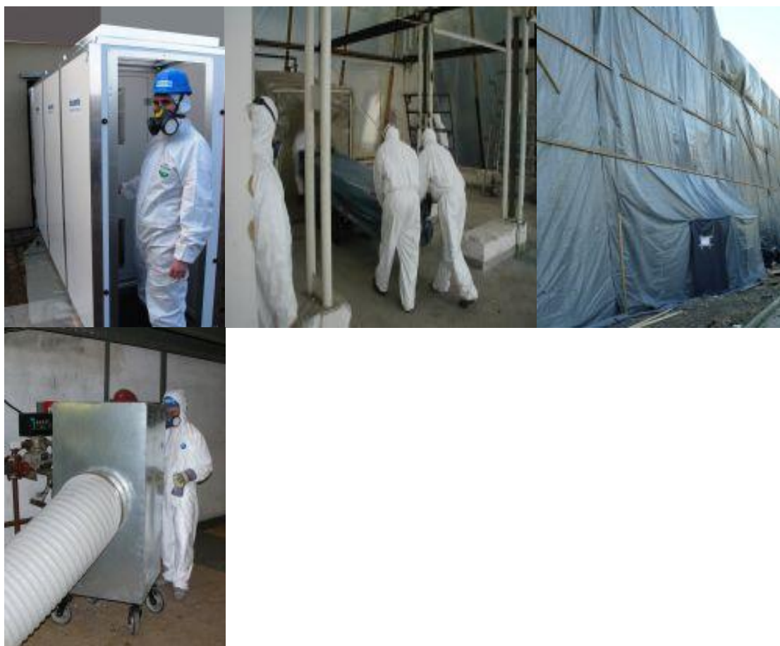
Obrázek č. 4 - Správné odstranění azbestu na stavbách
