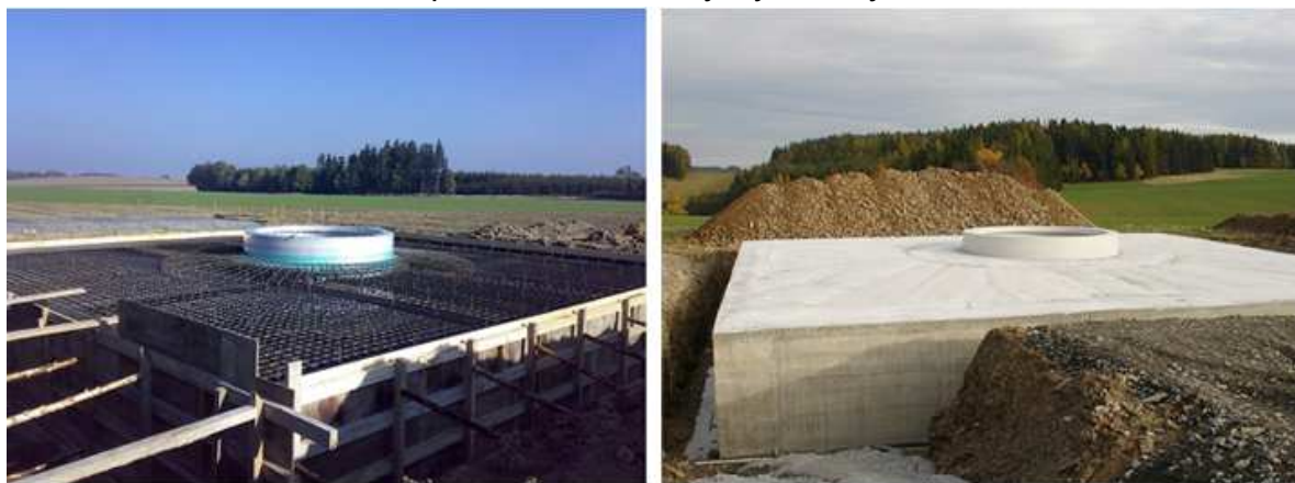
Obr. 30 Armování s bedněním před litím a konečný, vytvrdnutý základ
