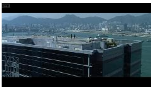
Obrázek 5 - Pohled z dálky na střechu...
