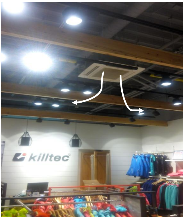
Obr. 11 Kazetová jednotka SkyStar 42 určena pro přívod vzduchu [vlastní zdroj]
