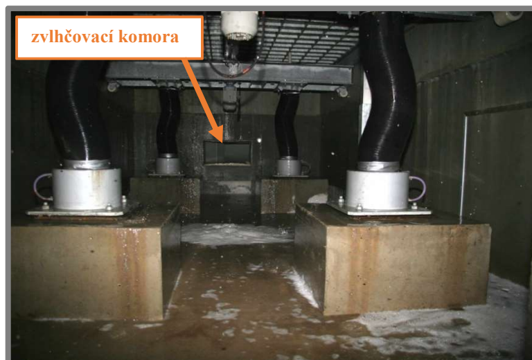
Obr. 6) Prostor pod klíčicí skříní, kde se využívá zvlhčování pomocí zvlhčovací komory. [Klíčirna ve sladovně Mšeno]
