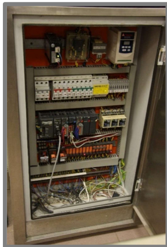
Obr. 17) Ukázka využití automatu DL205 v aplikaci stávající mikroskladovny ve VÚPS, a.s. v Brně.
