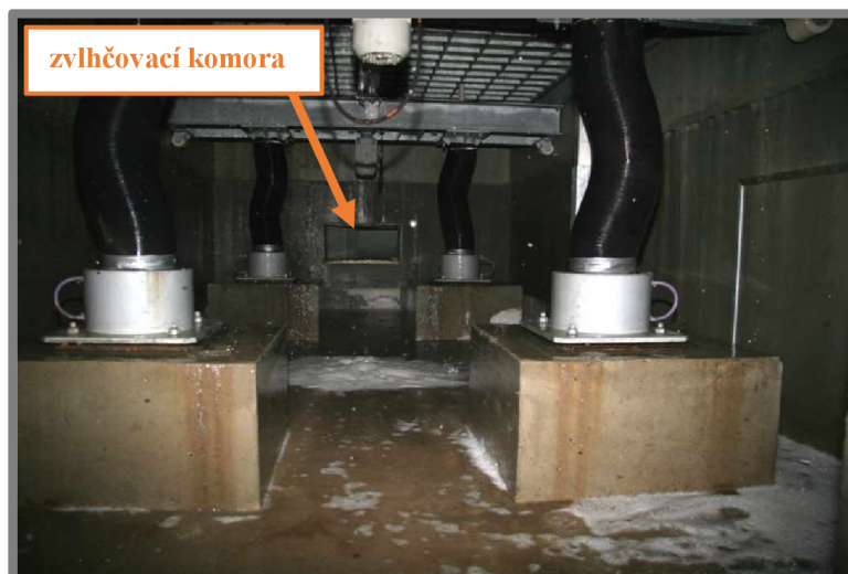
Obr. 6) Prostor pod klíčicí skříní, kde se využívá zvlhčování pomocí zvlhčovací komory. [Klíčirna ve sladovně Mšeno]
