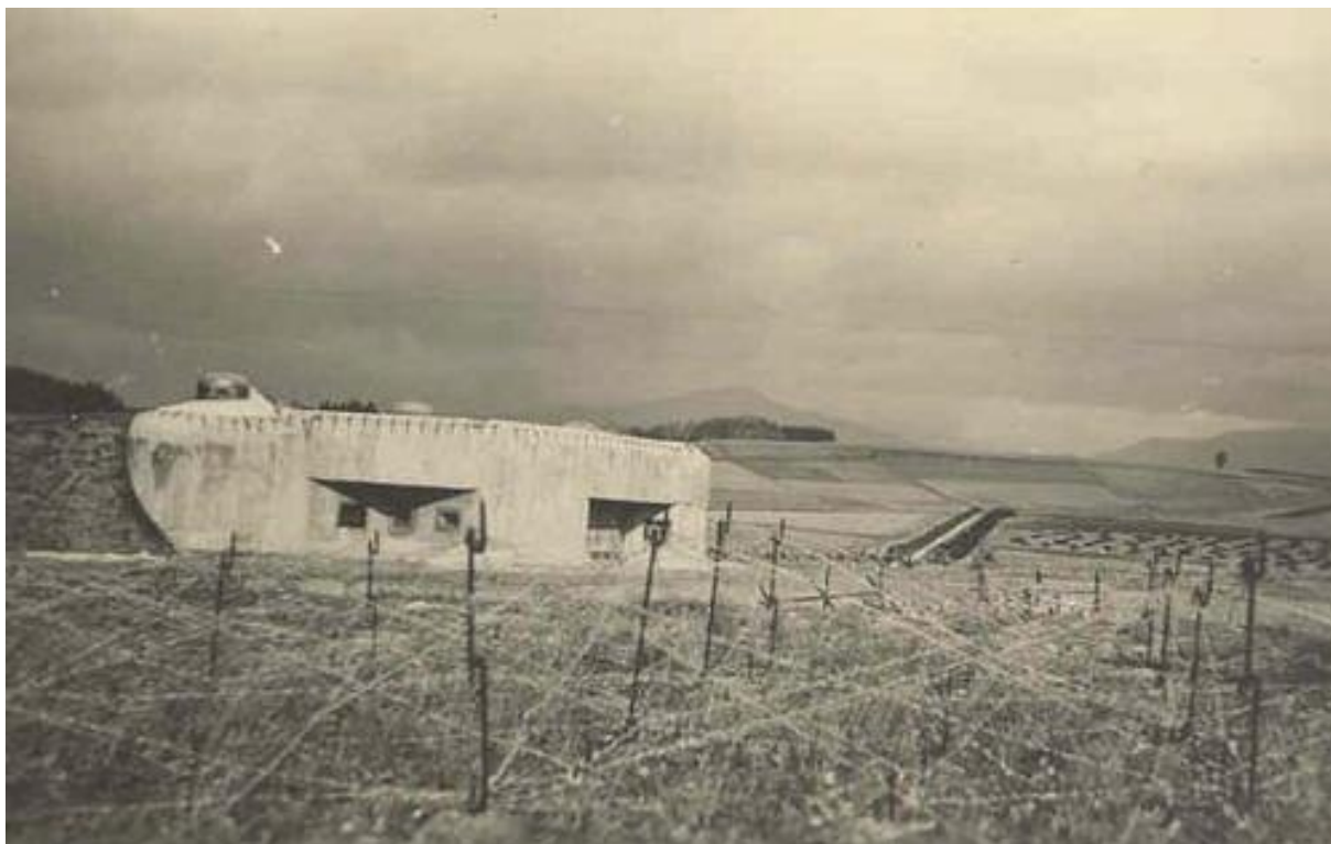
Příloha č. 2 – Fotografie – Izolovaný pěchotní srub, K-S 16. Foto KHV Brno
