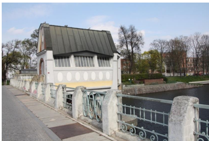
Obr.18: Most přes řeku kolem vodní elektrárny (Kamila Cupalová, 2.4.2019)
