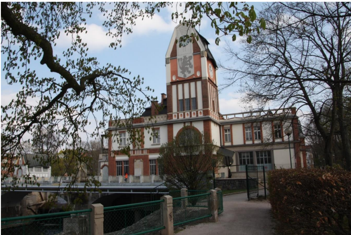
Obr. 17: Vodní elektrárna Hučák (Kamila Cupalová, 2.4.2019)
