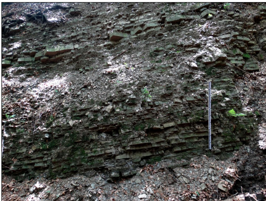
Obr. 20: Část výchozu č. 4 v defilé masivu Kobylské, foto autor – 15. 6. 2019. Měřítka 1m.
