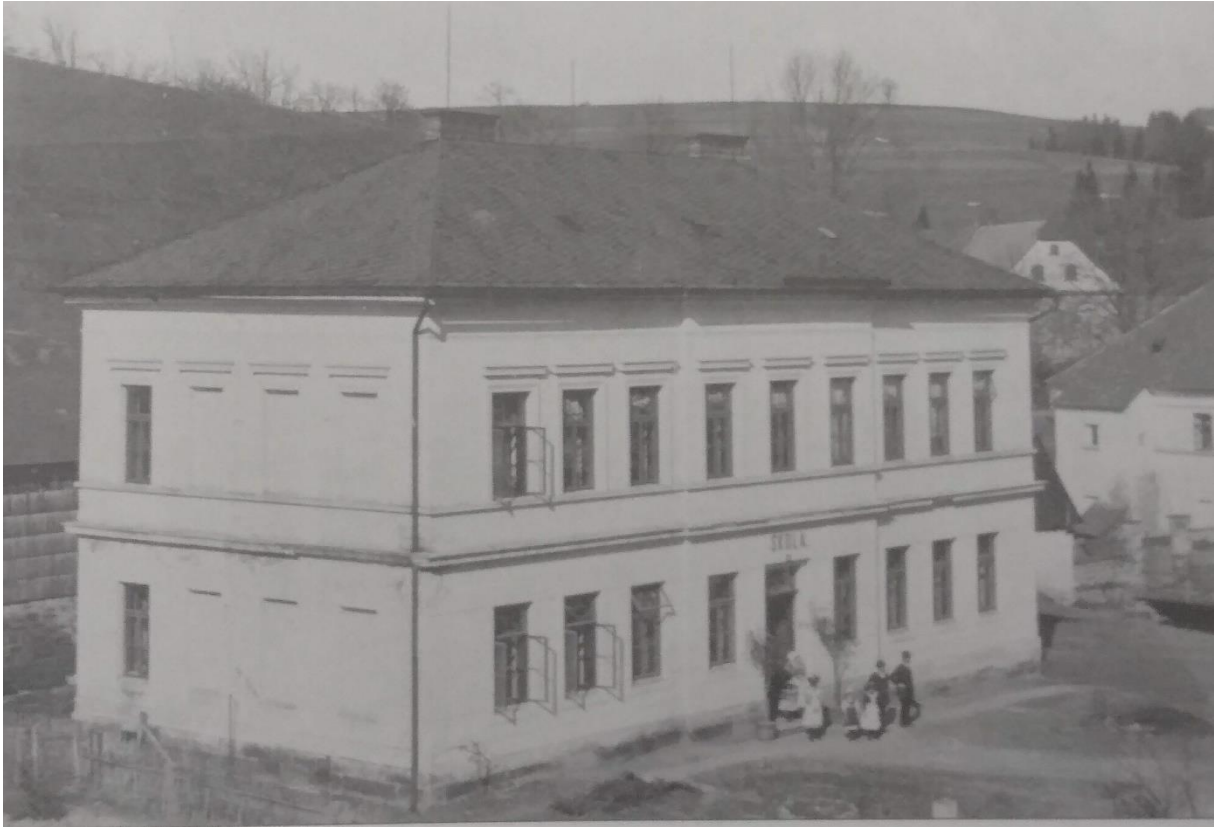
Obr. 3 - Budova čtvrté klášterecké školy (výuka 1886 - 1919), konec 19. století (SIBERA, M. Chaloupky pod horama . Kláštec nad Orlicí, 2009, str. 15)
