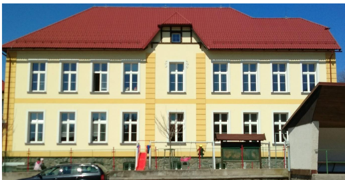
Obr. 6 - Budova Masarykovy základní školy v Klášterci nad Orlicí, současnost (Foto: autor)
