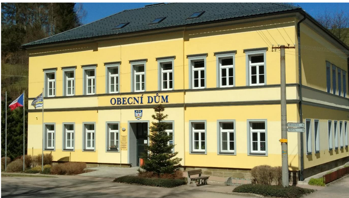
Obr. 4 - Budova čtvrté klášterecké školy v roce 2021, dnes Obecní dům (Foto: autor)
