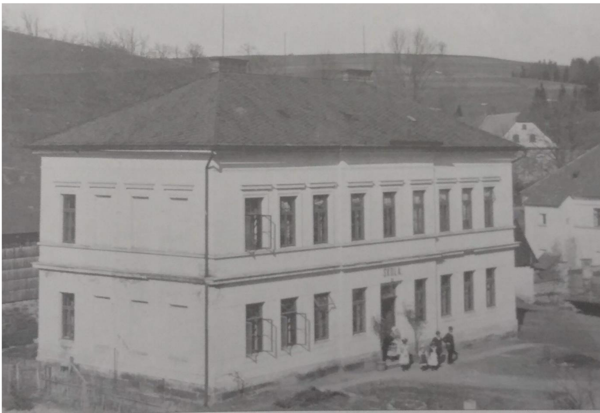
Obr. 3 - Budova čtvrté klášterecké školy (výuka 1886 - 1919), konec 19. století (SIBERA, M. Chaloupky pod horama . Klášterec nad Orlicí, 2009, str. 15)
