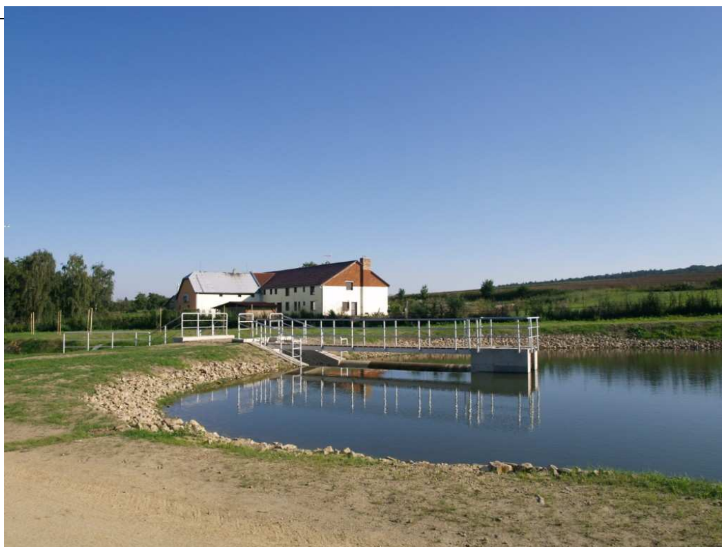
Obr. 1: Celkový pohled od příjezdové komunikace
