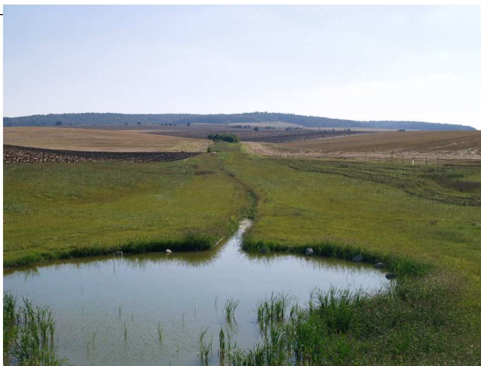
Obr. 1: Pohled na ZU2 z koruny hráze suché nádrže SO1
