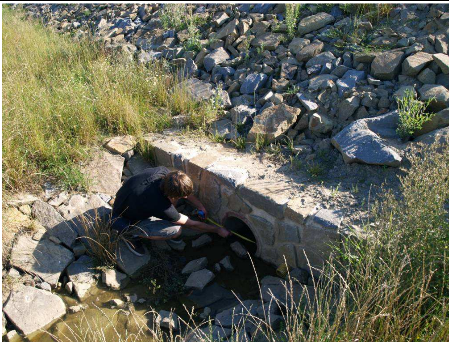
Obr. 3: Příkop P8 napojující se na trubní výúst spodní výpusti suché nádrže SO1
