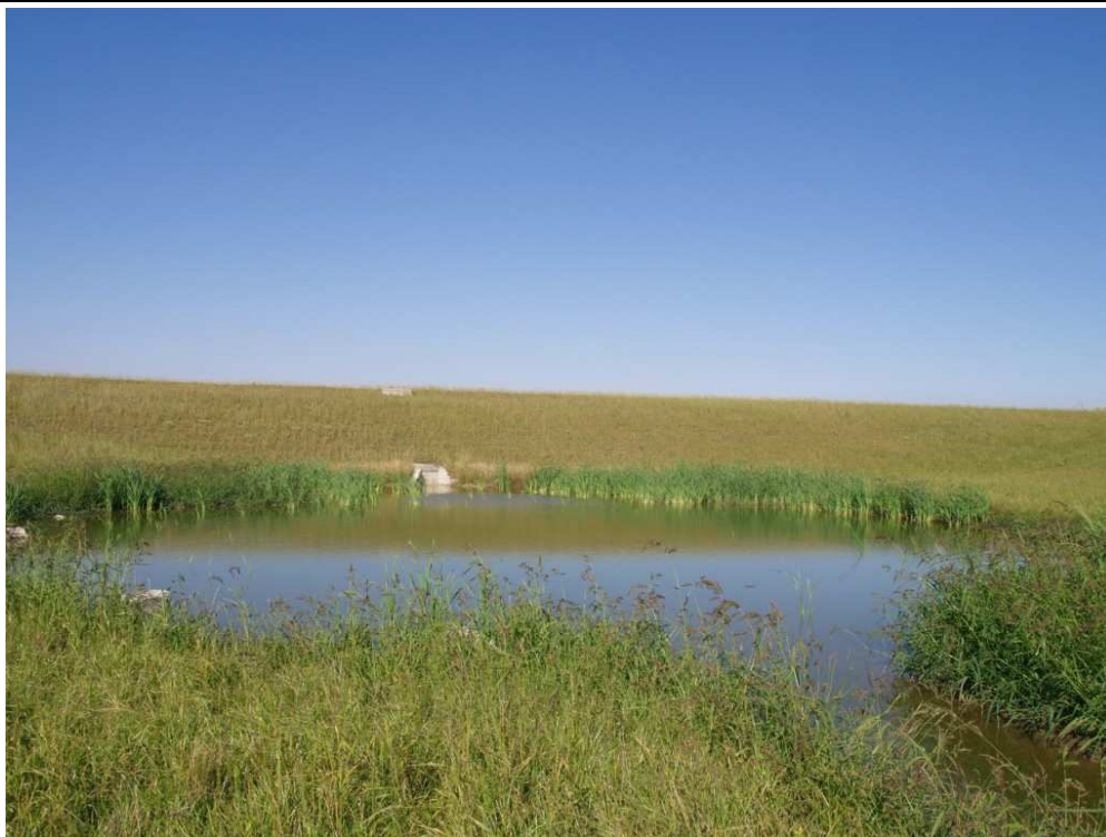
Obr. 4: Celkový pohled z povodí
