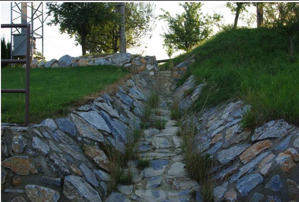
Obr. 7: Dlážděný svod příkopu těsně nad státní silnicí III. třídy směr Pacetluky
