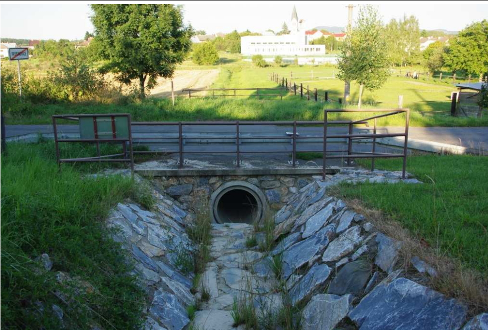
Obr. 7: Dlážděný svod příkopu těsně nad státní silnicí III. třídy směr Pacetluky
