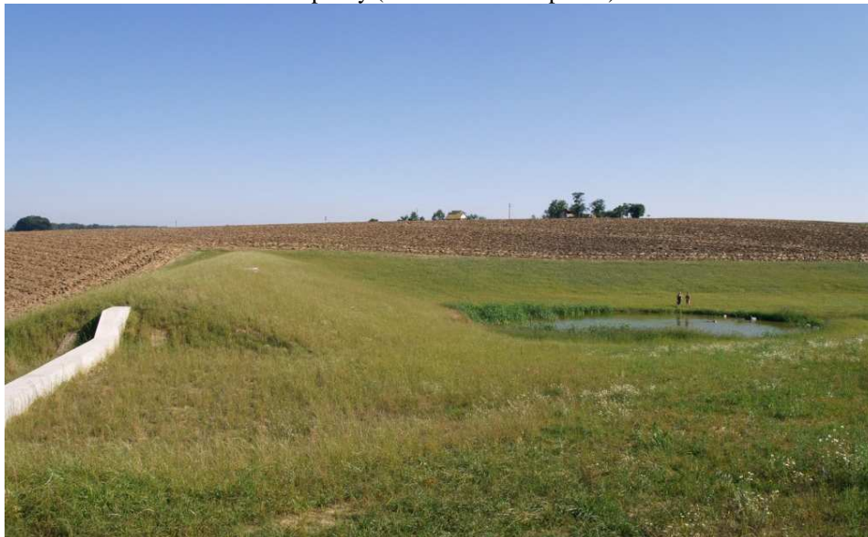
Obrázek 10: Protierozní nádrž v k. ú. Lutopecny (foto Jana Chaloupková)
