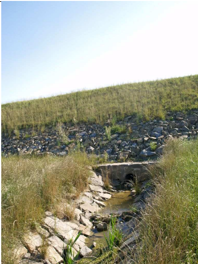
Obr. 5: Vyústění pod hrází
