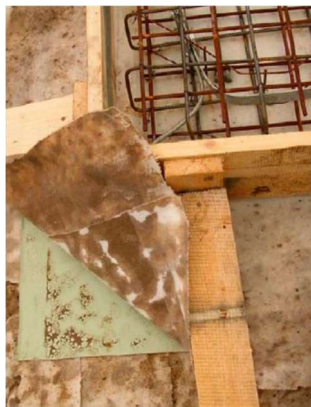
Obrázek 15 – Hydroizolace pod deskou (zdroj HAZUCHA, 2011).
