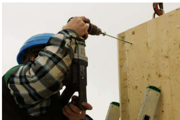
Obrázek 18 – Aplikace konstrukčního vrutu do spoje CLT panelů (zdroj Novatop-System).
