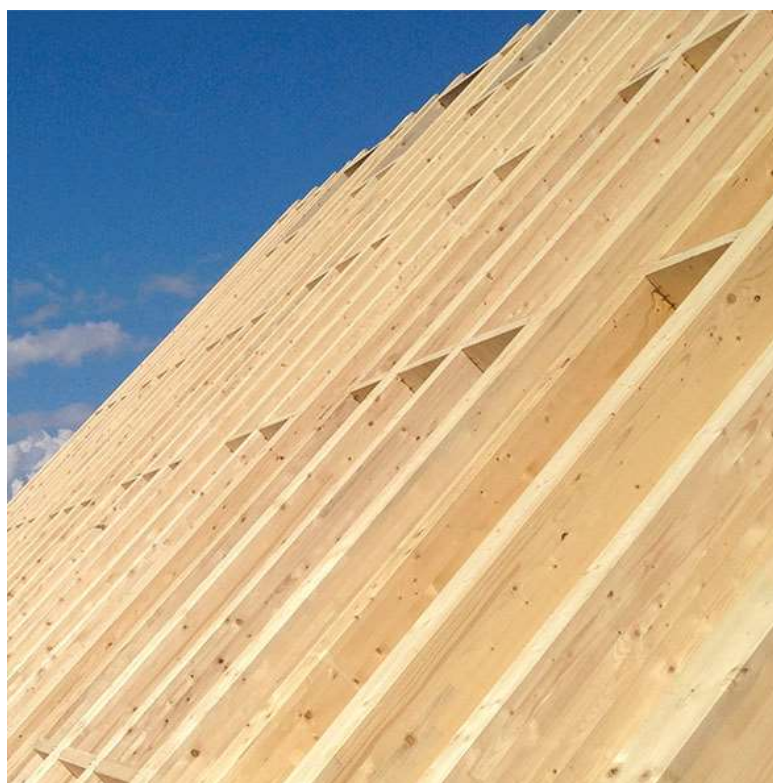
Obrázek 6– Konstrukce střechy Novatop Open (zdroj Novatop-system.cz)
