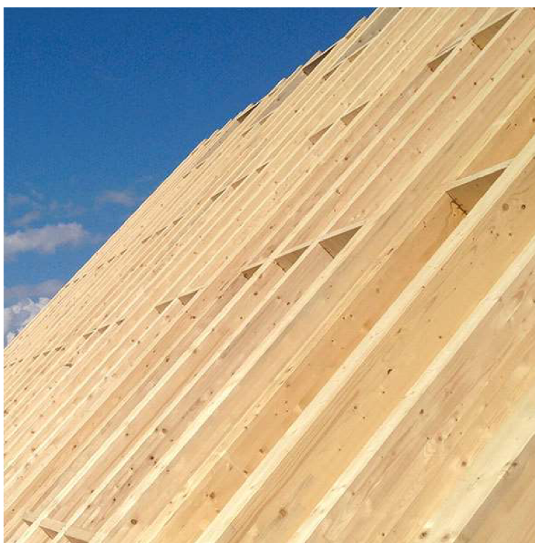
Obrázek 6– Konstrukce střechy Novatop Open (zdroj Novatop-system.cz)
