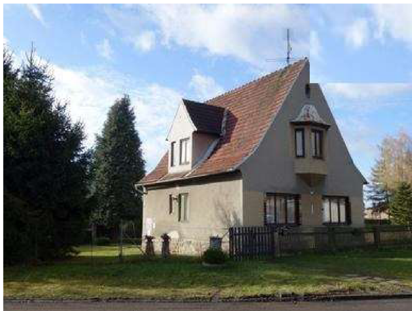
Obrázek 1– Současný stav domu (zdroj autor).
