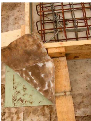
Obrázek 15 – Hydroizolace pod deskou (zdroj HAZUCHA, 2011).
