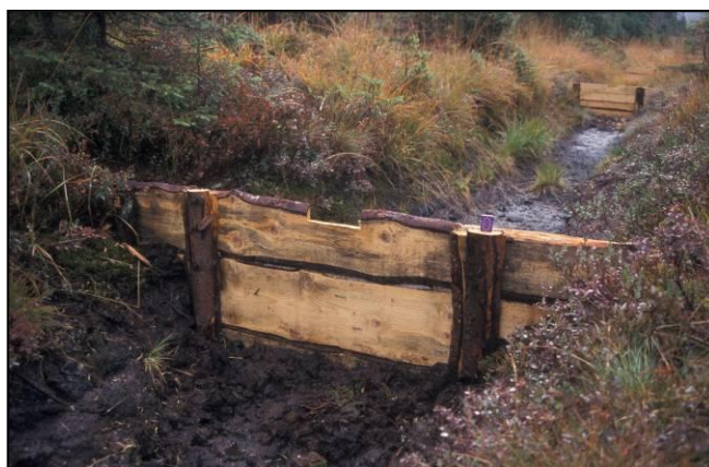
Obr. 31 : Pohled na hráz ze svisle zarážených fošen (vlevo) a příčně položených ostře řezaných prken. Autor: M. Kořen
