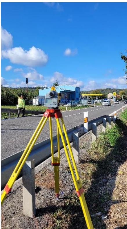
Obrázek 21 Měření nivelačního pořadu [autor]
