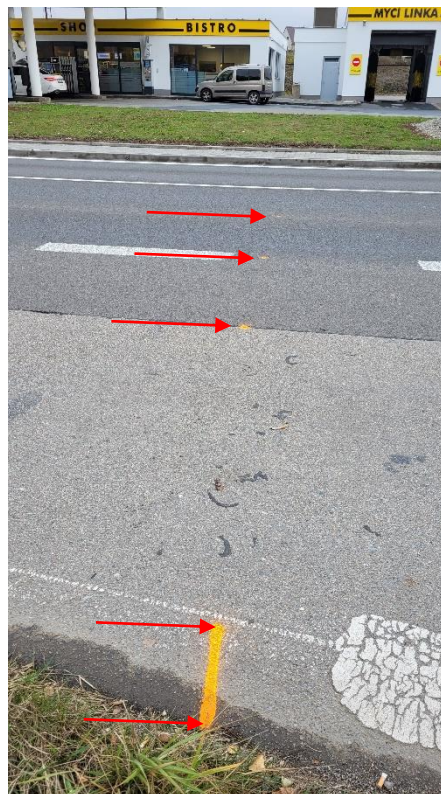
Obrázek 24 Vyznačení profilu na zpevněné části povrchu [autor]
