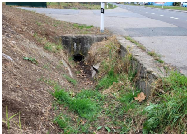
Obrázek 26 Zaměření skutečného provedení stavby podélného propustku a přilehlého okolí [autor]
