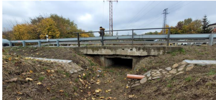
Obrázek 27 Zaměření skutečného provedení stavby příčného propustku č. 23-307P a přilehlého okolí [autor]
