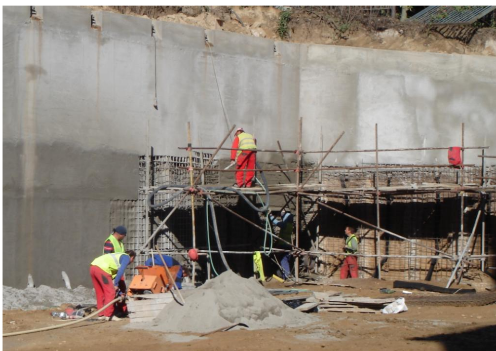
Obrázek 35: provádění nástřiku
