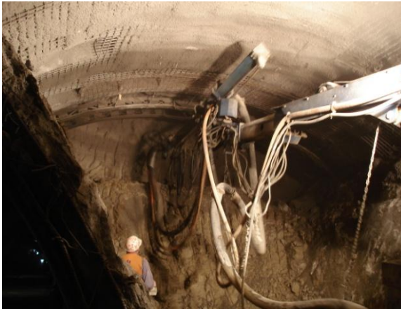
Obrázek 4: strojní provádění nástřiku
