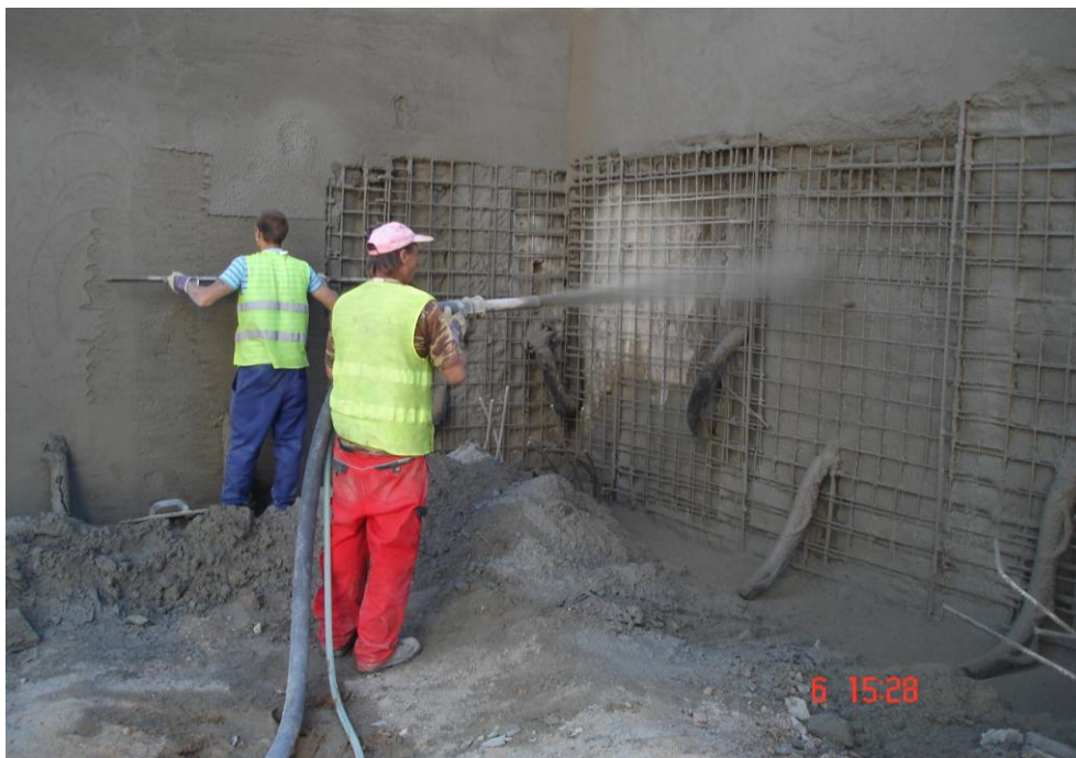
Obrázek 30: realizace nástřiku a následná úprava povrchu
