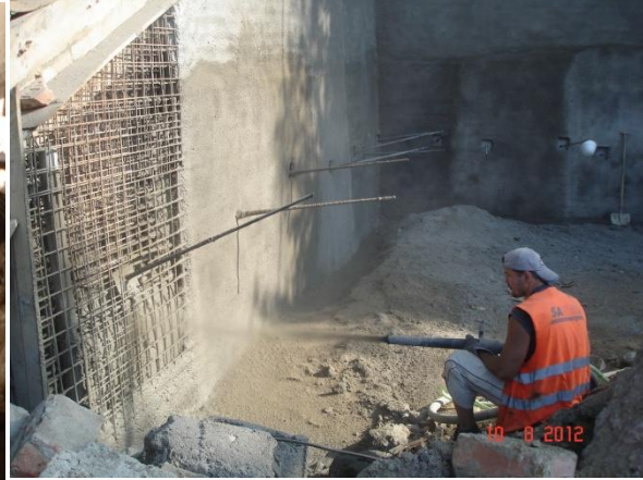
Obrázek 5: manuální provádění nástřiku
