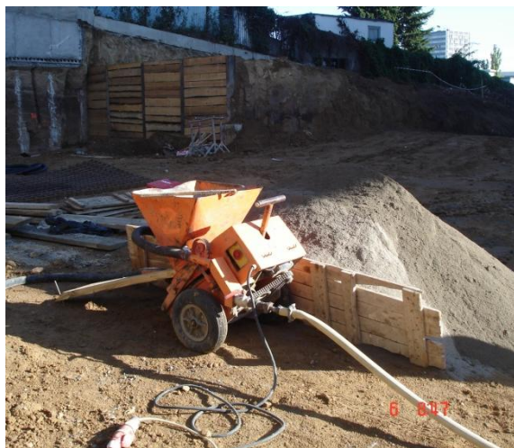
Obrázek 13: stroj pro provádění nástřiku suchou cestou
