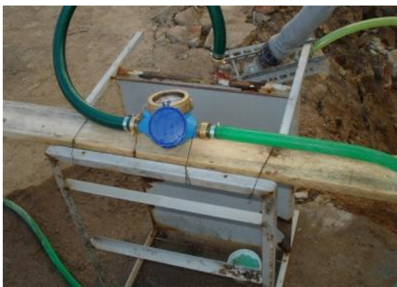
Obrázek 9: provádění měření množství záměsové vody
