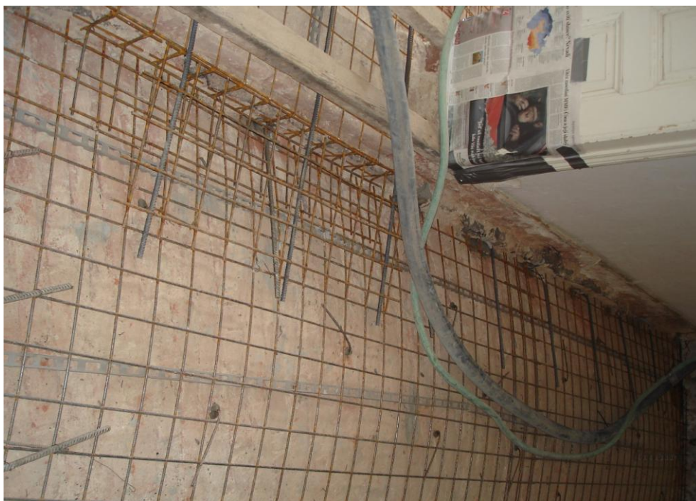
Obrázek 29: provádění zesílení konstrukce klenby
