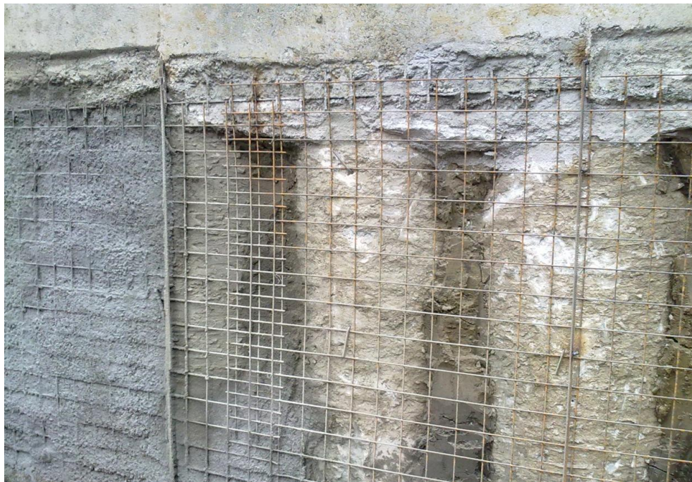
Obrázek 32: podklad připravený pro realizaci nástřiku
