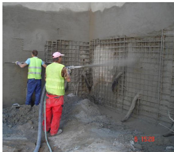
Obrázek 14: provádění nástřiku
