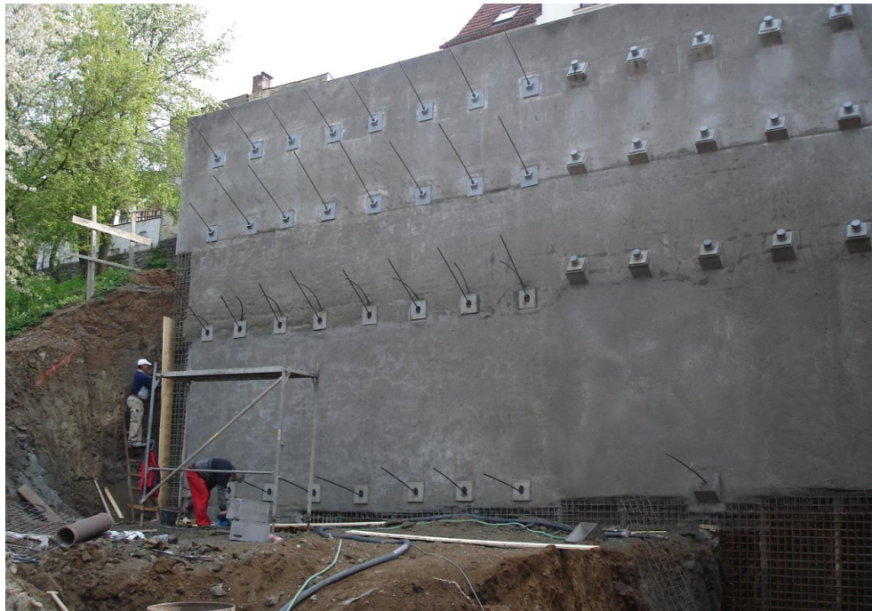
Obrázek 33: konstrukce pro provedení nástřiku a provedení povrchové úpravy
