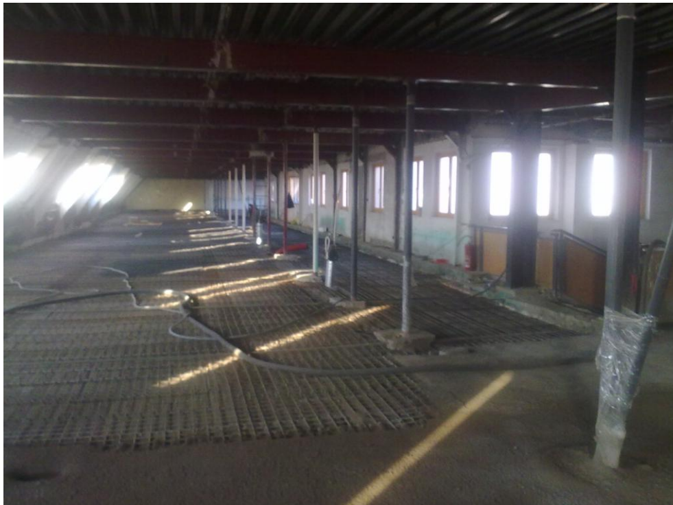
Obrázek 28: provádění rekonstrukce stropní konstrukce
