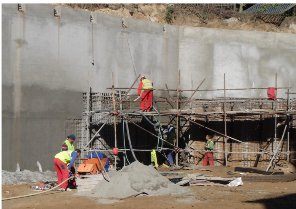
Obrázek 35: provádění nástřiku
