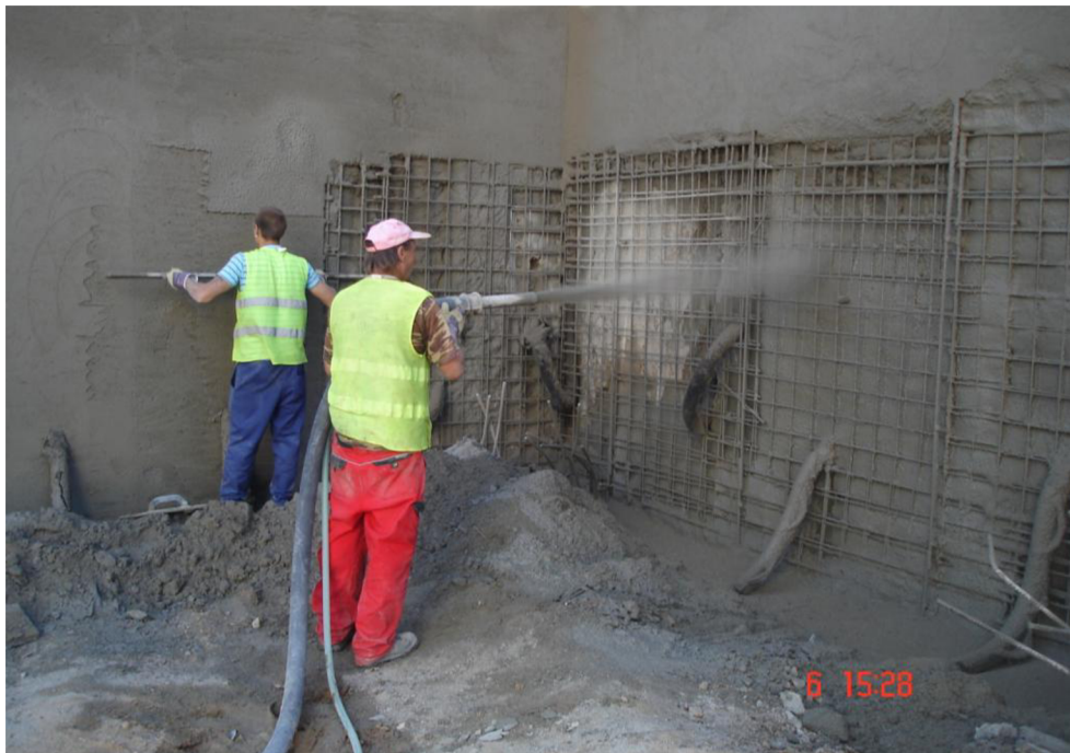
Obrázek 30: realizace nástřiku a následná úprava povrchu
