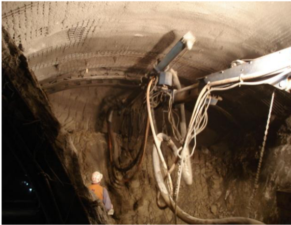
Obrázek 4: strojní provádění nástřiku
