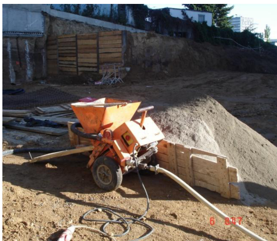
Obrázek 13: stroj pro provádění nástřiku suchou cestou
