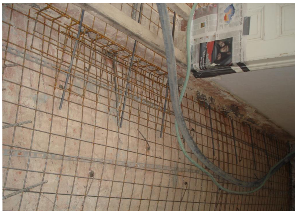
Obrázek 29: provádění zesílení konstrukce klenby
