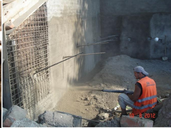
Obrázek 5: manuální provádění nástřiku
