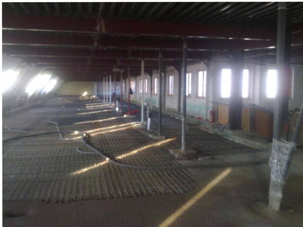
Obrázek 28: provádění rekonstrukce stropní konstrukce
