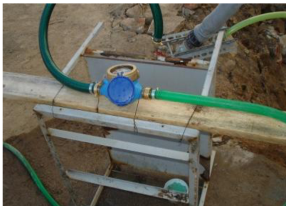
Obrázek 9: provádění měření množství záměsové vody
