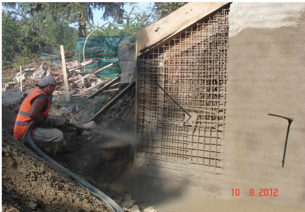
Obrázek 31: realizace nástřiku
