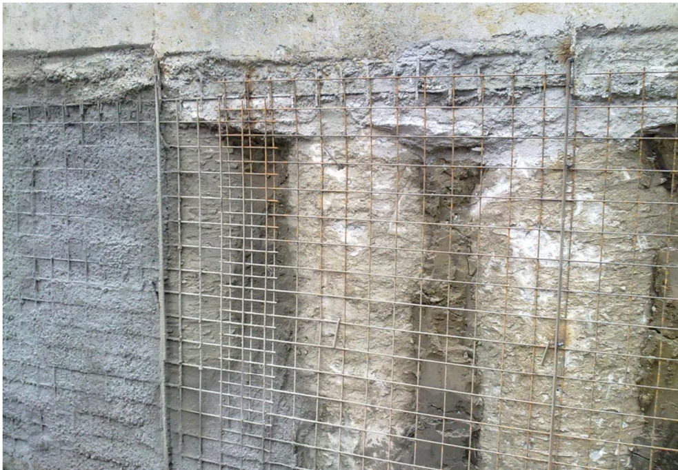
Obrázek 32: podklad připravený pro realizaci nástřiku
