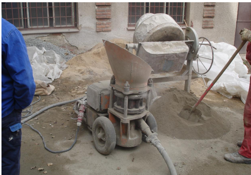
Obrázek 34: strojní zařízení pro realizaci nástřiku suchou cestu
