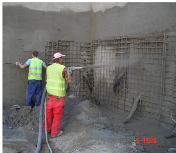
Obrázek 14: provádění nástřiku
