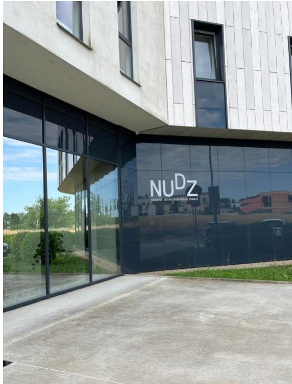
Obrázek 8: Vstup budovy ústavu
