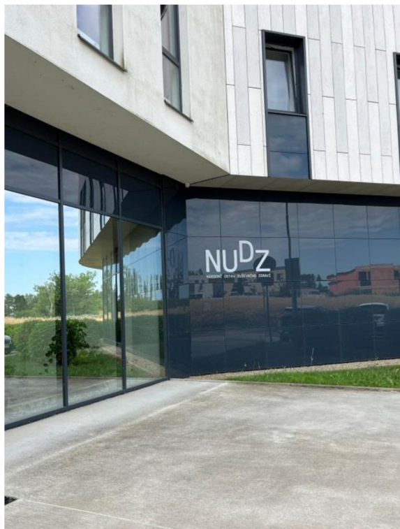
Obrázek 8: Vstup budovy ústavu
