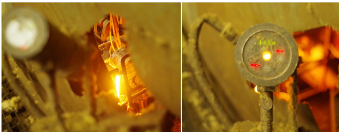
Obrázek 42 Pohled na výtok ze stávajícího pyrometru
