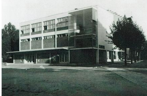
Obrázek č. 42 – dobová fotografie sokolovny - https://vysocina.rozhlas.cz/autorem-jihlavske-sokolovny-je-znamy-architekt-bohuslav-fuchs-budova-se-za-84-7956271
